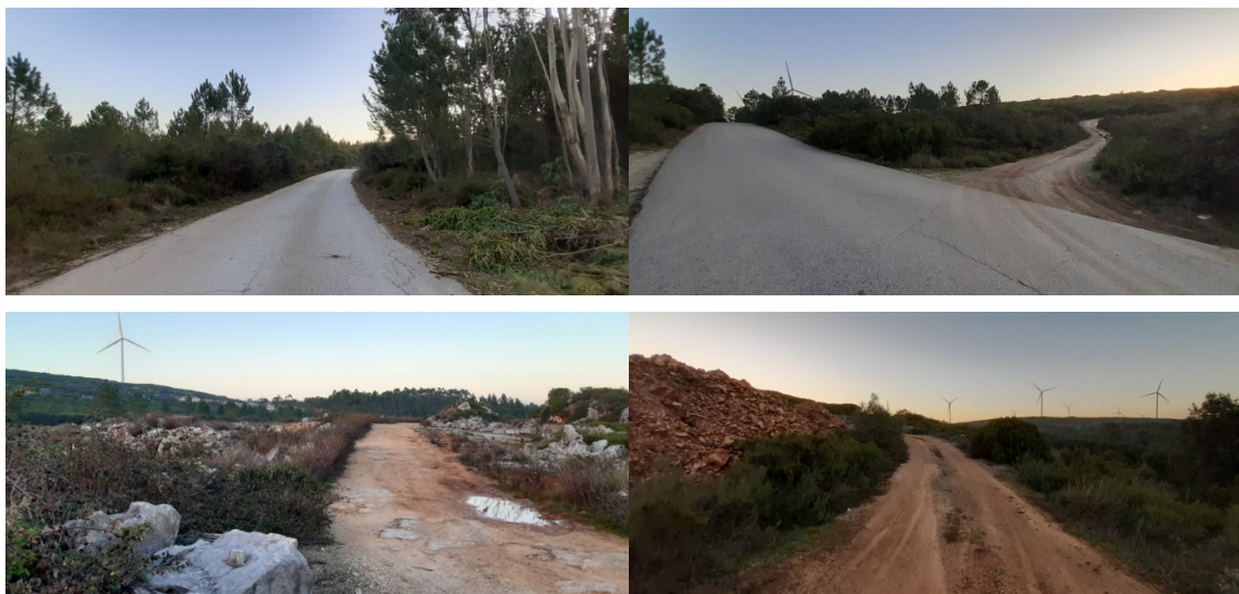
Foto 1a – Estrada municipal de acesso à pedreira da “Cabeço Sobreiro”. Foto 1b – Entroncamento com o caminho em terra batida. Fotos 1c e 1d – Aspetos do caminho em terra batida na vizinhança da área da pedreira.
